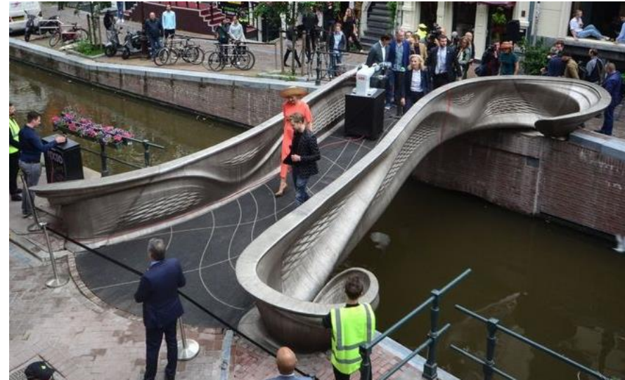
Pont en acier imprimé par WAAM installé dans la ville d'Amsterdam par la société MX3D
