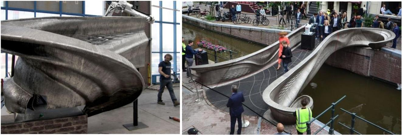
Figure 22 : Pont en acier imprimé par WAAM par la société MX3D, installé dans la ville d'Amsterdam
