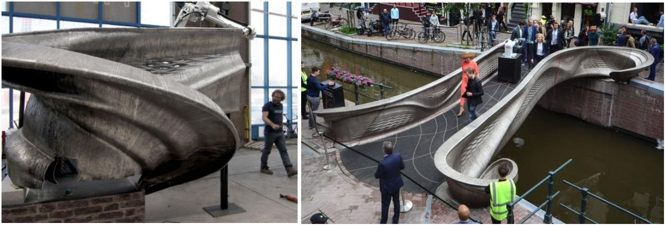
Figure 24 : Pont en acier imprimé par WAAM par la société MX3D, installé dans la ville d'Amsterdam
