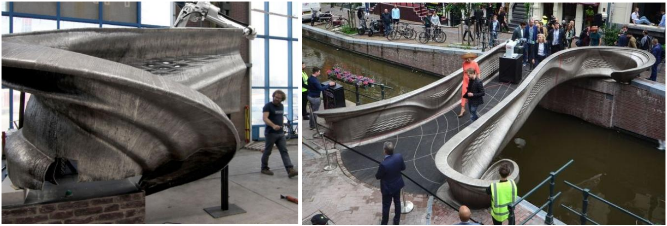
Figure 27 : Pont en acier imprimé par WAAM par la société MX3D, installé dans la ville d'Amsterdam
