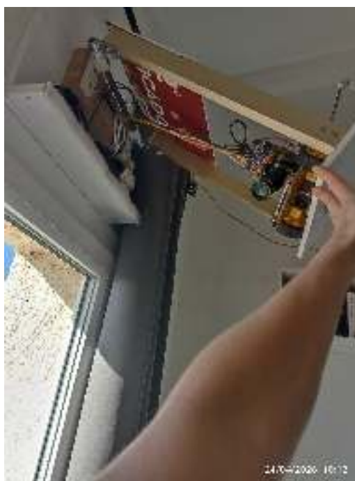
Bras articulé permettant le passage de la fenêtre
